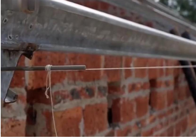
**Prepare un dispositivo de referencia horizontal para la instalación, por ejemplo, colocando una línea de construcción horizontal**
